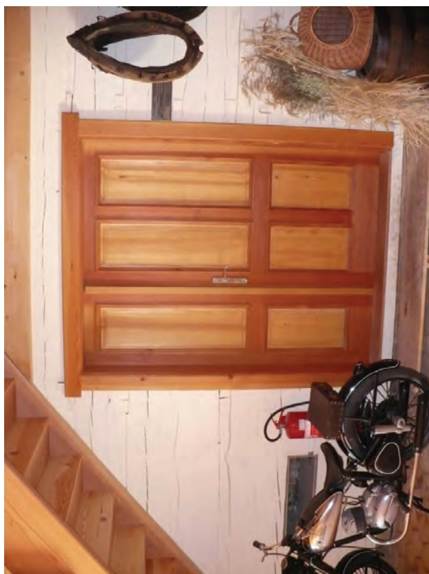
Výplňové dveře z douglasky, výplně jsou ze smrku, povrchová úprava – lněná fermež.
