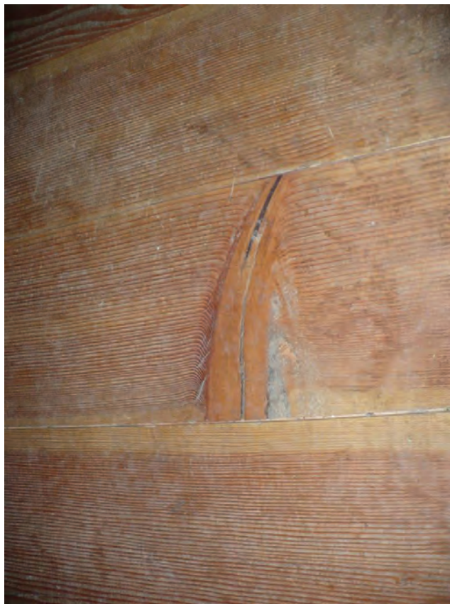
Rozměrný suk, který ztěžuje opravování.
