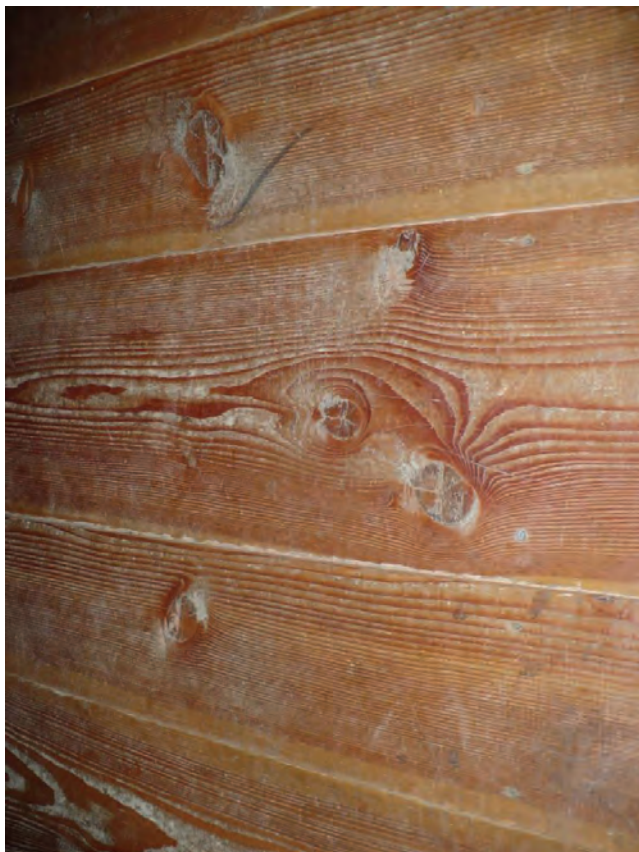
Podlaha ošetřená Iněnou fermeží – objekt ekocentra – prodejna vstupenek – intenzivní používání 7 let.
