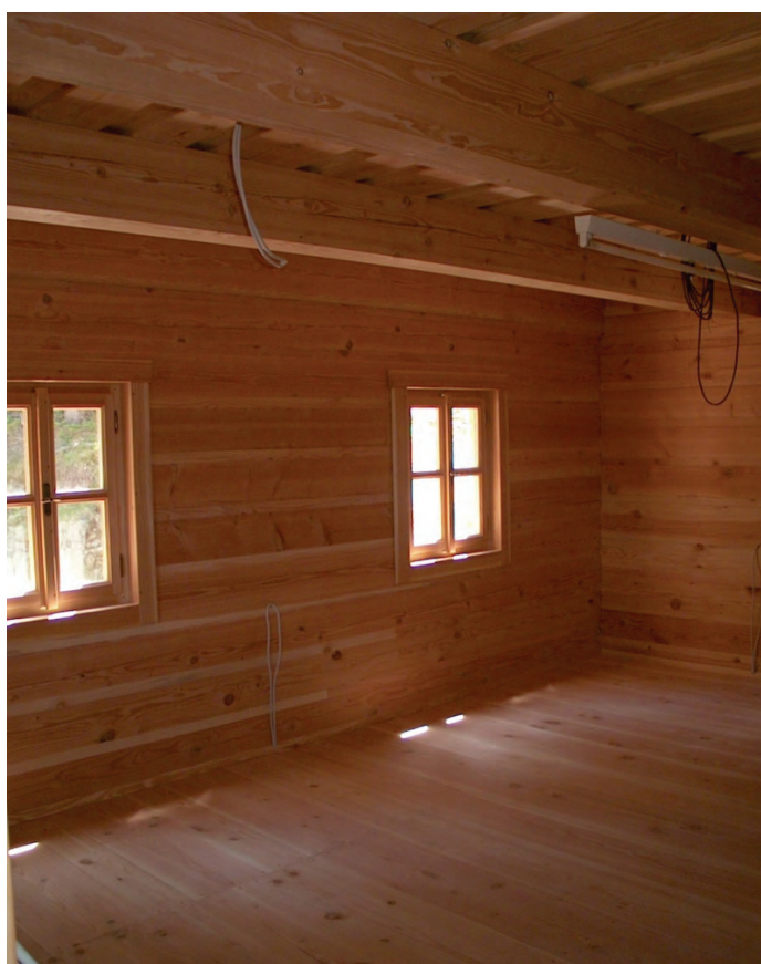
Douglaskový interiér – strop, stěny, podlaha, okna; před povrchovou úpravou – surové.
